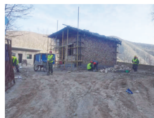
水厂建设现场
