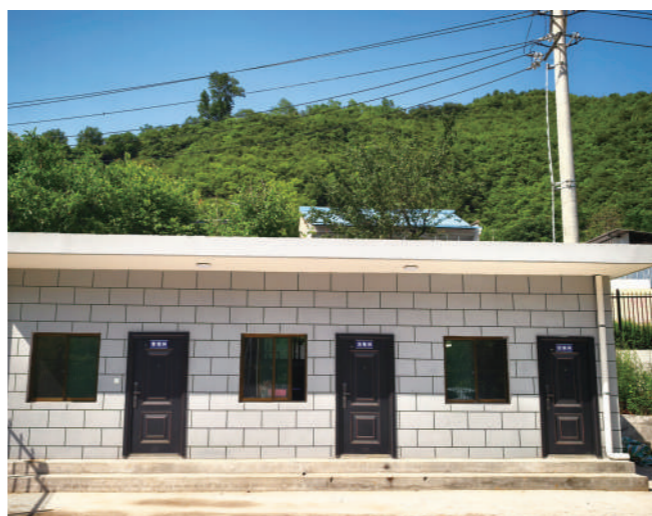
常家河供水站
