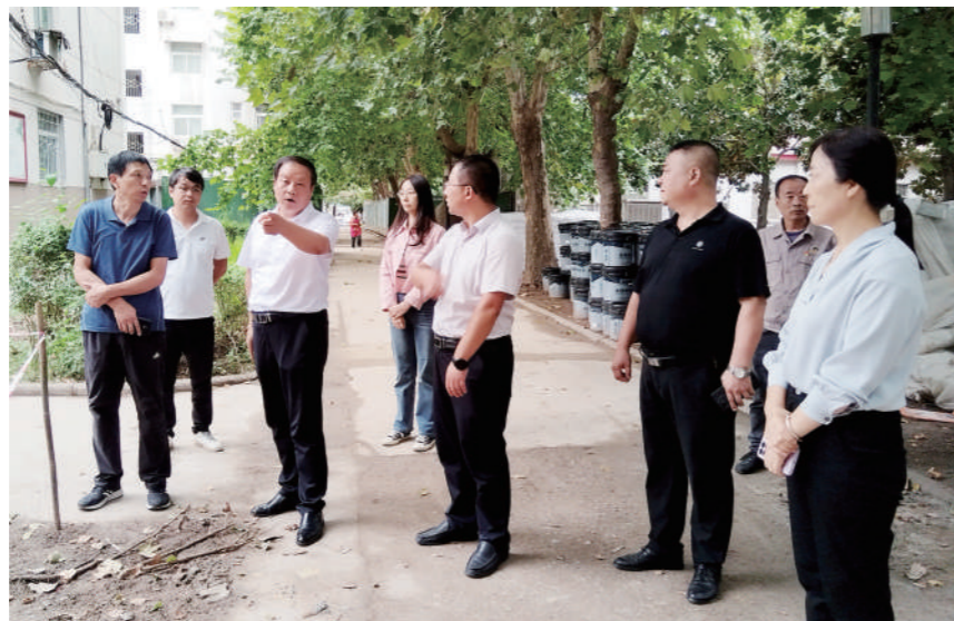
陈仓区政协主席苟晓明协调推进包抓老旧小区改造项目建设
