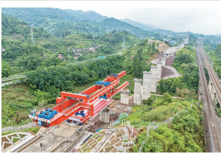
7月10日，在西渝高铁陈家沟特大桥建设现场，架梁机在进行首孔箱梁架设作业（无人机照片）。当日，中铁十四局工人将首孔长24.6米、重542吨的箱梁架设在西渝高铁重庆段陈家沟特大桥第一孔墩柱上，标志着西渝高铁重庆段箱梁架设施工正式启动。
