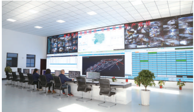
西北有色地矿集团权属铅锌集团铅铜山矿业公司调度指挥中心
