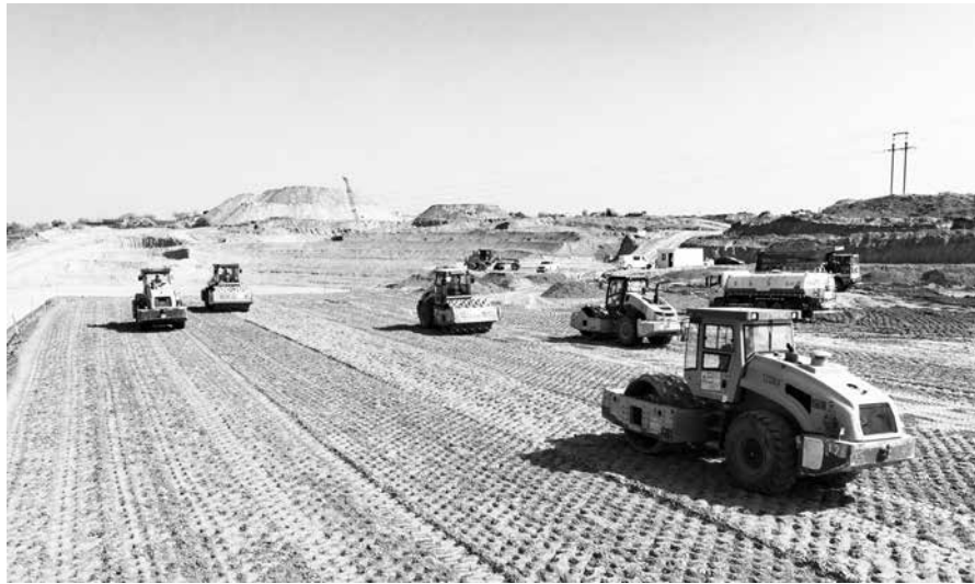
机场建设工地
