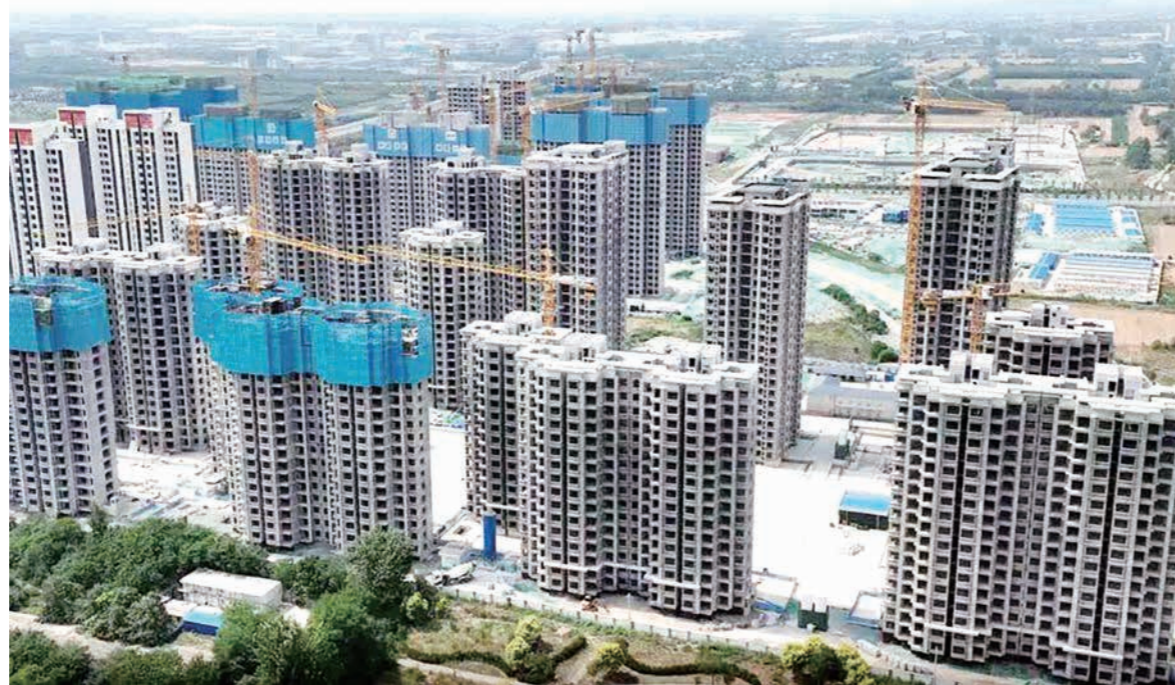
泾河丽舍项目建设现场
