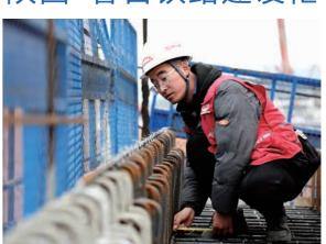
3月15日,中铁十一局技术人员在西十高铁陕西段 山阳跨福银高速特大桥工地测量钢筋间距。
