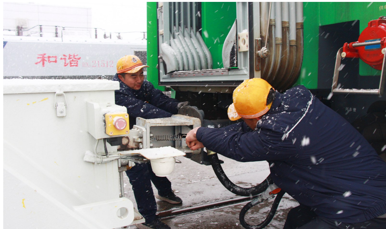
1月15日,受强冷空气影响,我省多地出现降温降雪天气,中国铁路西安局集团有限公司第一时间启动应急预案,加强线路设备的巡视检查,组织人员除雪除冰,加强运输组织,确保铁路运输安全有序。图为工作人员冒雪检修列车。
