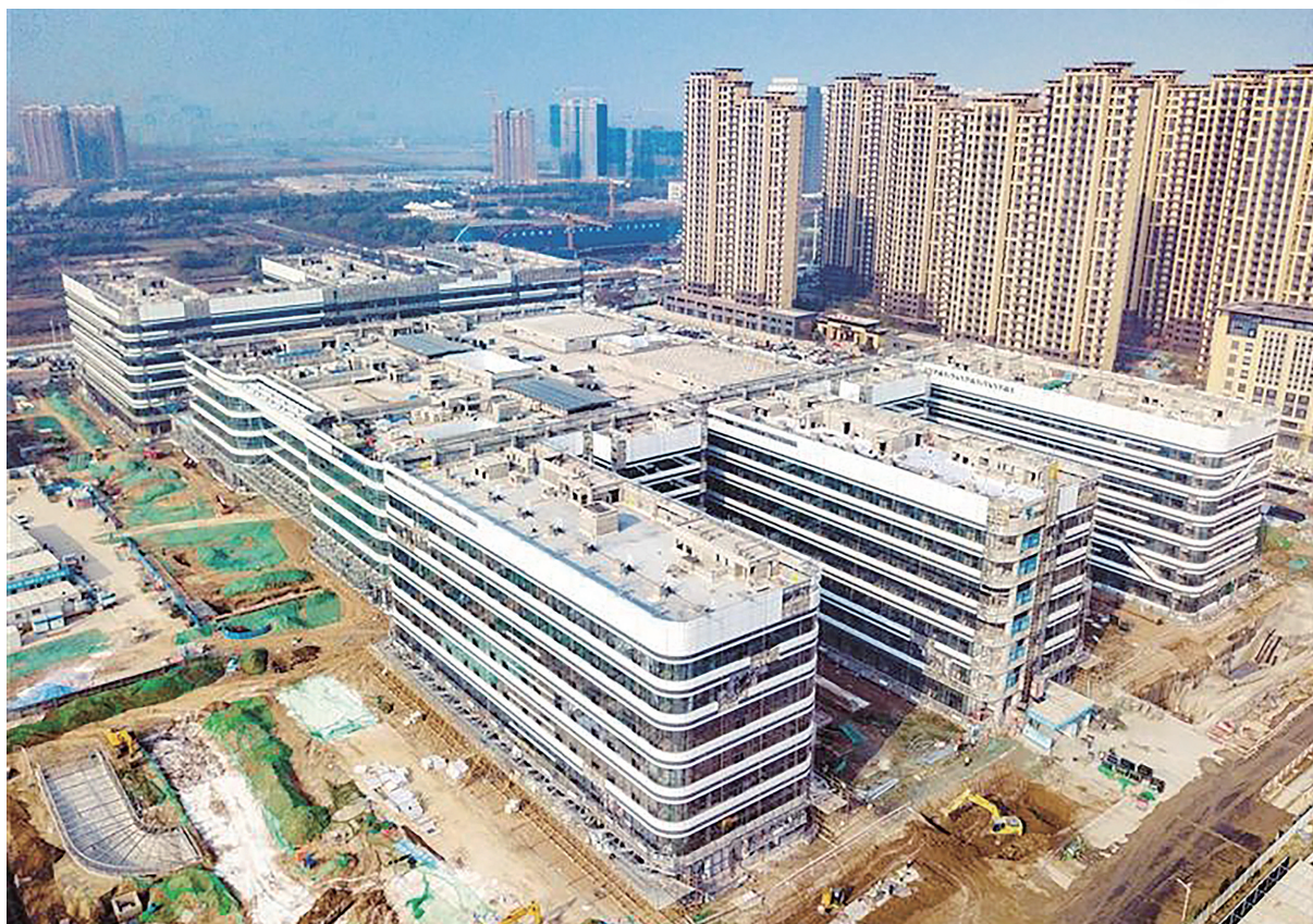
西咸新区泾河新城秦创原医疗健康科技产业园一期工程正在进行室外幕墙和室内装饰装修施工
