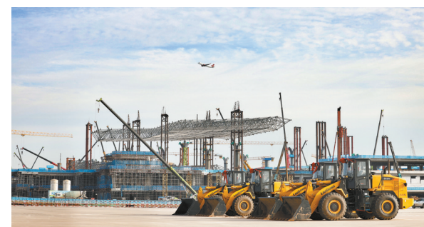
西安咸阳国际机场三期扩建工程项目
