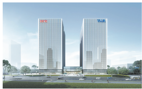
中电科太极西安产业基地项目
