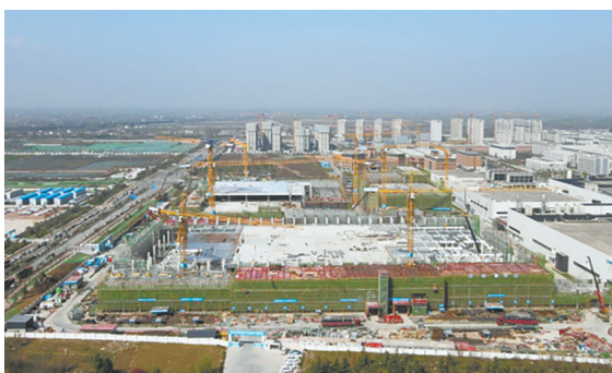
西安奕斯伟硅产业基地二期项目
