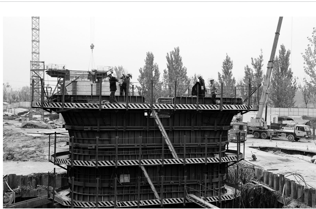
10月9日,中铁上海工程局西十高铁项目部施工人员在位于西安市的西十高铁跨沙河特大桥桥墩上施工作业。西十高铁沙河特大桥自今年年初开工以来,参建单位抢工期、赶进度,高标准、高质量推进项目建设。西十高铁沙河特大桥全长8397米,是西十高铁全线最长桥梁,也是全线的重点工程之一。西安至十堰高速铁路是陕西“米”字形高铁网中重要的一“捺”,该条高铁途经西安、商洛、十堰3市,接入已建成的武汉至十堰高铁,新建正线长255.7公里,设计速度为每小时350公里,计划于2026年开通运营。记者 杜静波 摄影报道
