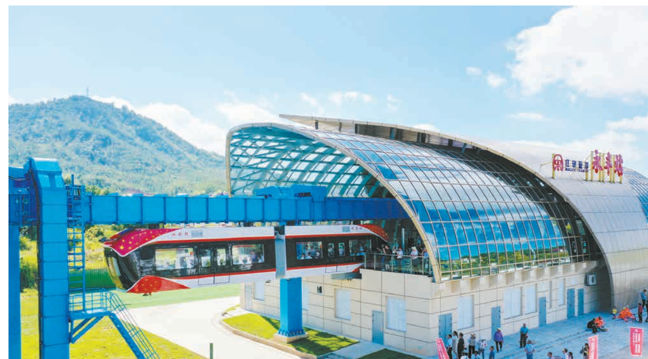
8月9日,“红轨”试验线列车驶出车站(无人机照片)。
